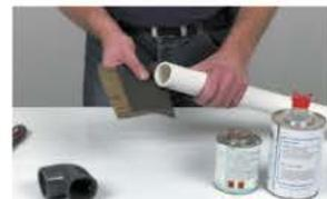
Bien dépolir avec du papier de verre le tuyau et le raccord, puis nettoyer les deux parties avec le décappant.
