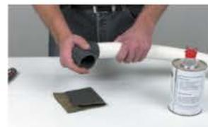
Emboîter à fond jusqu'au repère initialement tracé. Eliminer les excédents de colle, ne pas contraindre à l'assemblage pendant 2 min pour le rigide et 3h pour le tuyau souple. Mise en pression 24h après.
