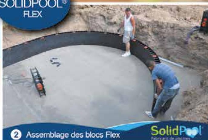
**2** Assemblage des blocs Flex
