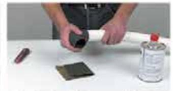
Emboîter immédiatement à fond jusqu'au repère initialement tracé. Éliminer les excédents de colle, ne pas contraindre à l'assemblage pendant 2 mn pour le rigide et 3h pour le tuyau souple. Mise en pression 24h après.
