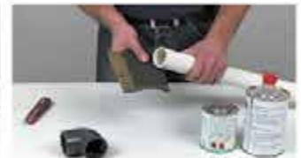
Bien dépolir avec du papier de verre le tuyau et le raccord, puis nettoyer les deux parties avec le décapant.
